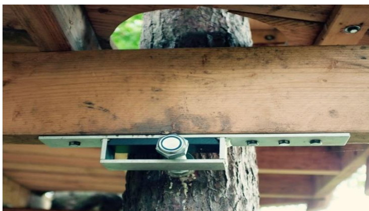
Slika 5. Prikaz spoja grede i stabla pomoću TAB-a (izvor: https://www.hamerenhark.nl , autor: Hamer en Hark)
